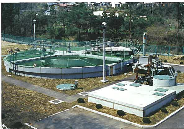
日本下水道事業団と共同研究開発した日本初の「プレハブ式下水処理場（群馬県中之条町）」
