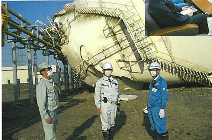
現地調査(仙塩浄化センター 4月13日)
