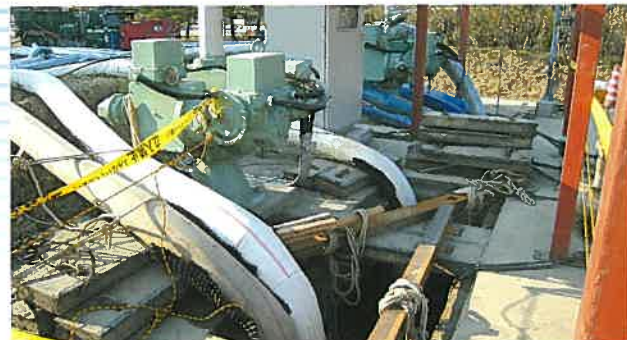
水中ポンプによる応急対応
