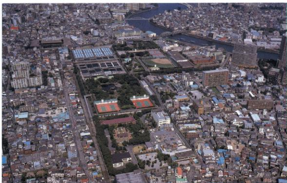
三河島水再生センターの全景
